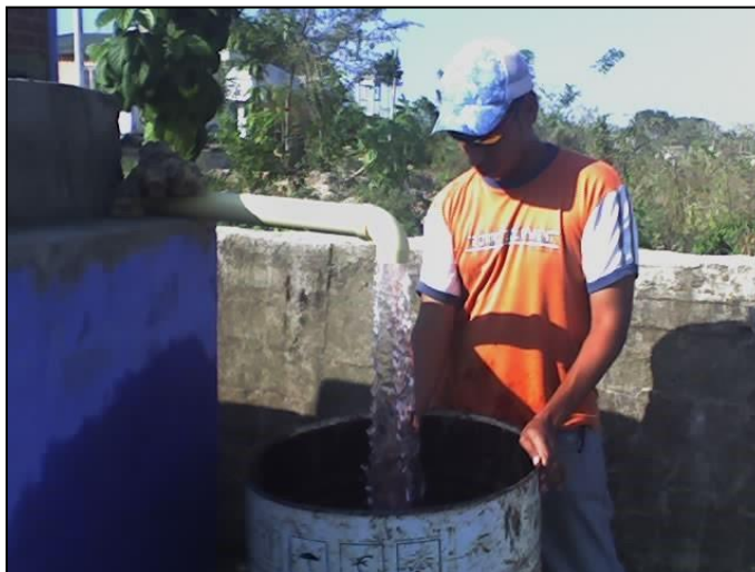
Fotografía 3.21. Prueba de bombeo pozo de Turbaco.
