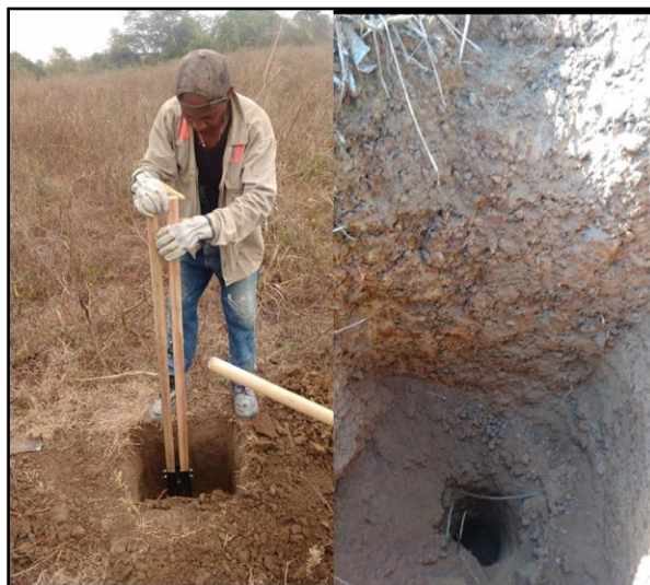
Fotografía 3.54. Elaboración de cajuelas de 60 cm de largo x 60 de ancho x 70 cm de profundidad.
