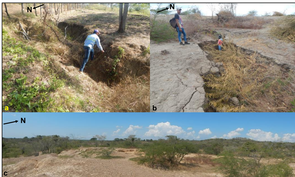
Fotografía 3.50. Carcavamiento. a) Municipio de Manatí; b) Finca Villa Chile, Municipio de Usiacurí; c) San José de Carretal.
